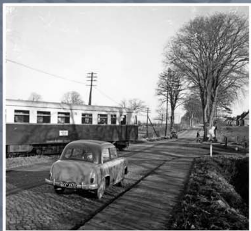
▲ Ein Zug auf der Bundesstraße 75 in Blumendorf (1956): Damals gab es hier weder Schranken noch Ampeln. Züge überquerten die Straße so langsam, dass sie im Notfall innerhalb weniger Meter zum Stehen kommen konnten. (Quelle: Kreisarchiv Stormarn/ Marfels)
