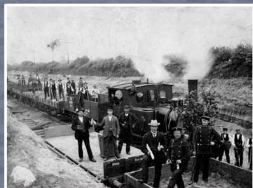
▲ Bau der EBOE-Bahntrasse 1905/1906 (Quelle: Gemeindecarchiv Sülfeld - Sammlung Bärwald)
