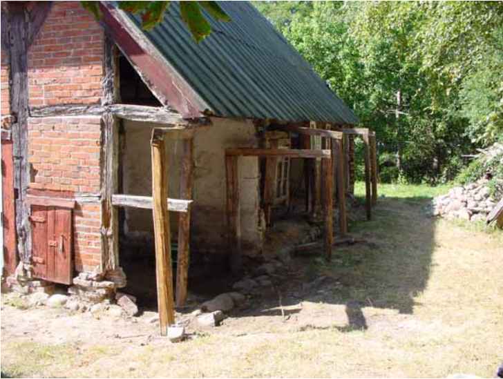
Ansicht der Nordwand nach Abbruch der selbigen im August 2003
