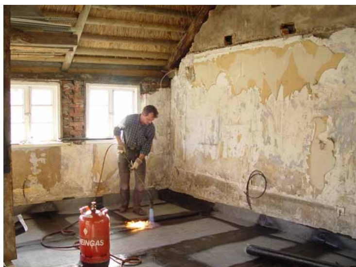
Verlegen der Schweißbahnen für die Isolierung des Fußbodens gegen aufsteigende Feuchtigkeit im November 2004
