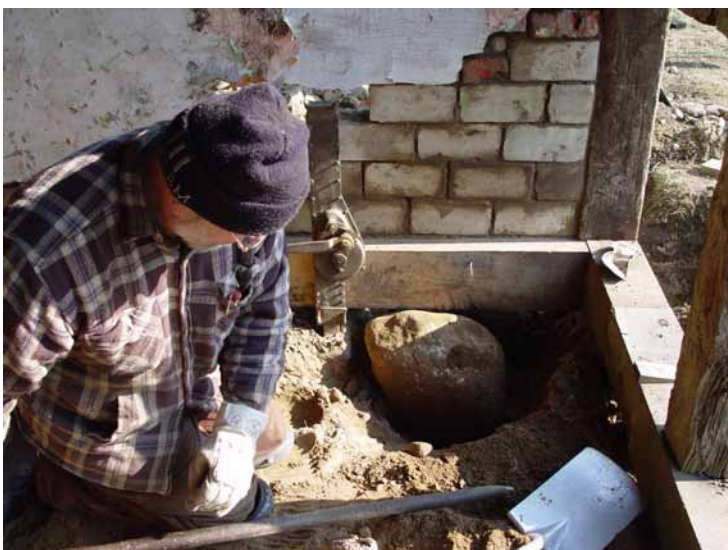
Setzen der Natursteinfundamente durch den Steinsetzer Dietmar Zuther im Feb. 2004
