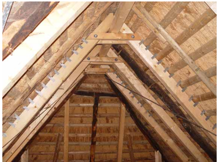
Der sanierte und verstärkte Dachstuhl im März 2009
