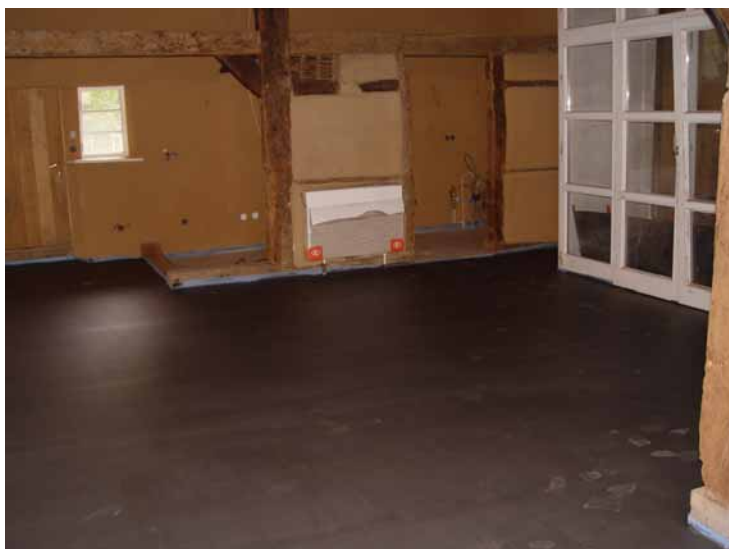
Der beschichtete Estrichfußboden im Juli 2009
