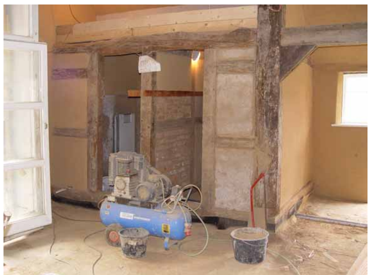
Aufbringen des Lehmfeinputzes auf die Innenwände im Mai 2009
