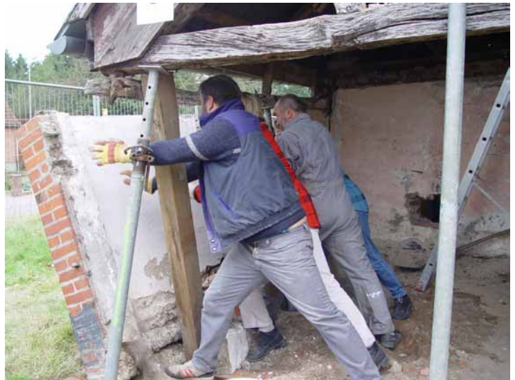
Abbruch der Südwand: Hier ist die Wandscheibe mit Zement vermauert; die Steine können leider nicht genutzt werden. November 2003
