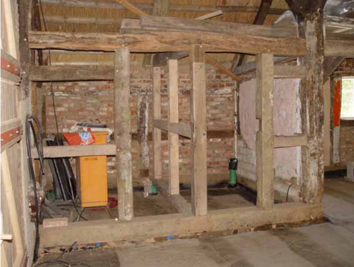
Das Innenfachwerk im zukünftigen Sanitärbereich, Mai 2005
