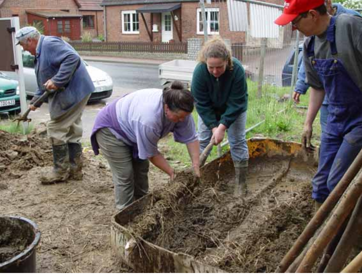
Herstellung der Strohlehmwickel für den Dach- schrägenausbau, Mai 2006
