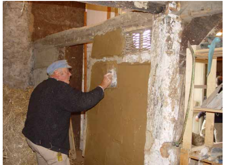
Aufbringen von Lehmfeinputz im Bereich der Innenwände im Mai 2007
