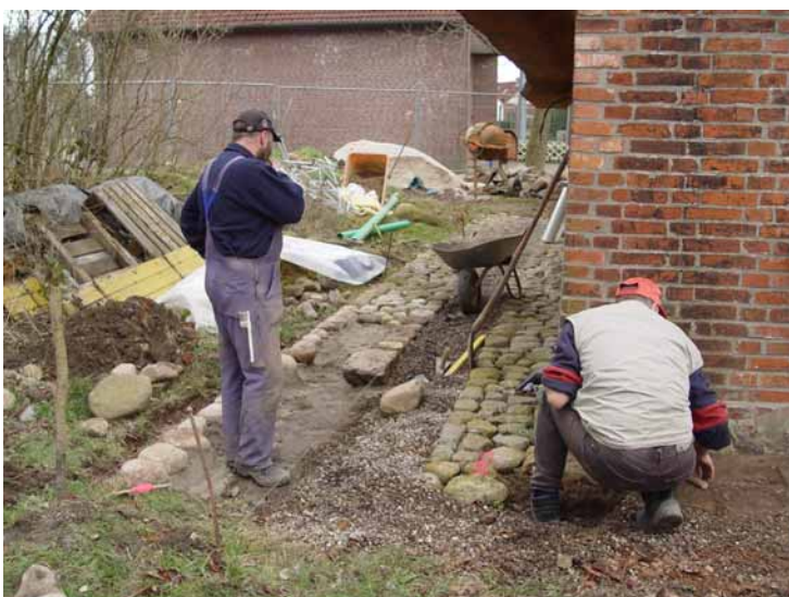
Fortführung der Pflasterarbeiten mit Natursteinpflaster im März 2009
