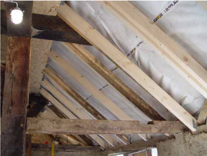
Sanierung der Dachschräge im Innenbereich der Südseite im Januar 2009
