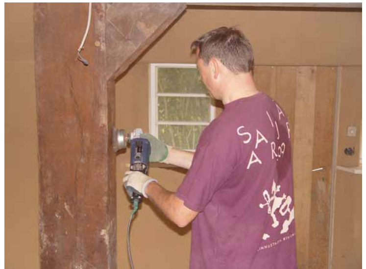
Reinigung der Holzbalken im Innenbereich im Juni 2009
