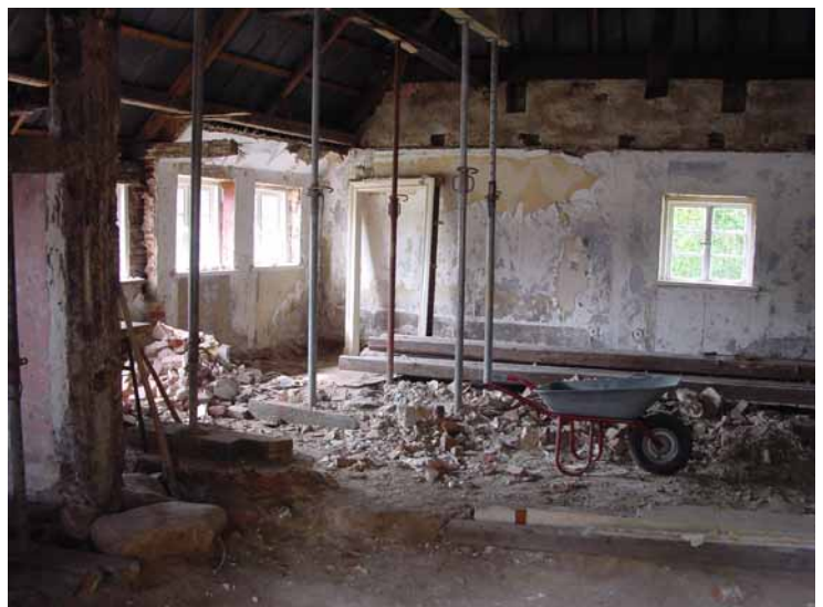
Innenansicht der Kate nach dem Abbruch der Innenwände im August 2003
