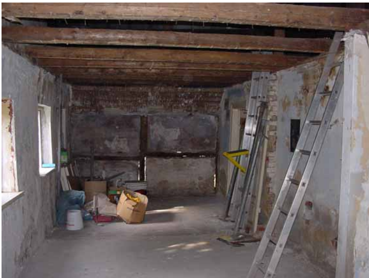
Der ehemalige Wohnbereich im Innern der Kate mit „Durchblick“ durch das Fachwerk der Nordwand im September 2002
