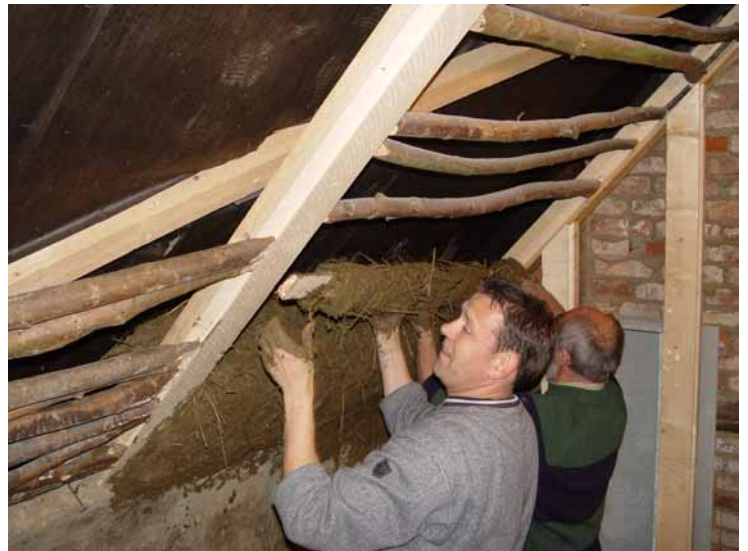
Ausbau der Dachschrägen mit Strohlehmwickeln im Mai 2006
