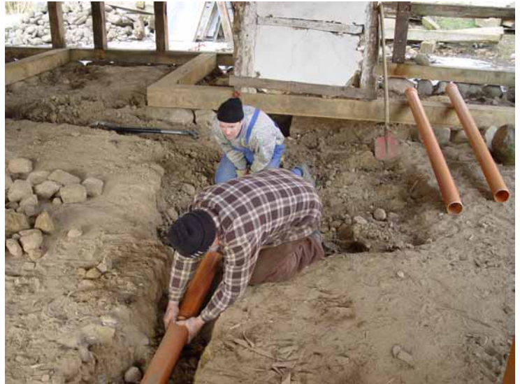
Verlegung der Abwasserleitung im Februar 2004
