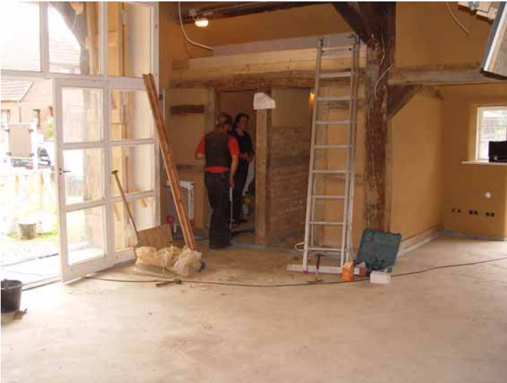
Der Estrichboden und die mit Lehmfeinputz verputzten Innenwände im Juni 2009
