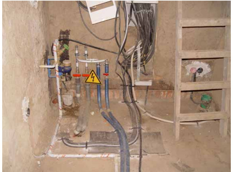
Verlegung der Heizungs-, Wasser- und Elektro- leitungen im April 2009
