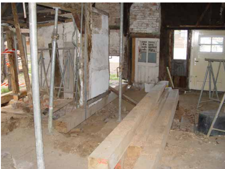
Setzen der Eichenschwellen im September 2003
