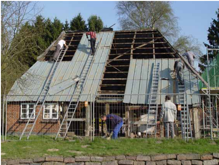
Abbruch des Blechdaches durch die Reetdachdecker unter Mit- hilfe von Mitgliedern des Katen- vereins im April 2004
