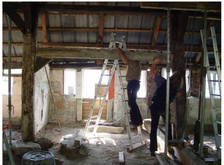
Einsetzen des Rähms zwischen den beiden südlichen Ständern im September 2003
