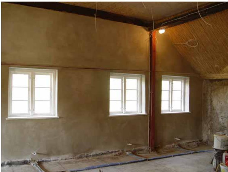
Verputzen der gemauerten Westwand mit Kalkmörtelputz im Mai 2009
