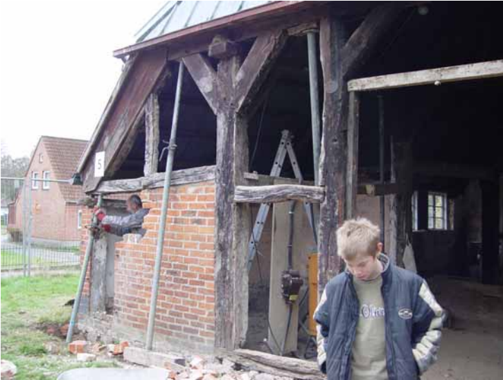
Sicherung der Fachwerkbalken durch Spindelstife beim Abbruch der Ostwand im November 2003
