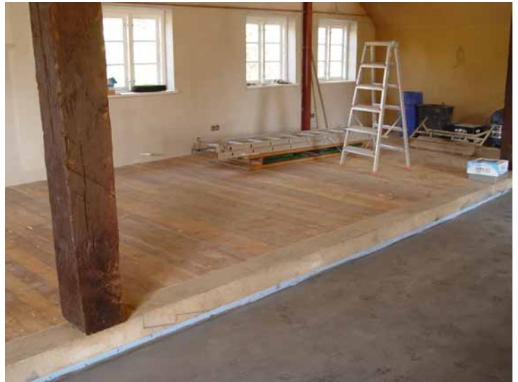
Der eingebaute Holzdielenfußboden im Juli 2009
