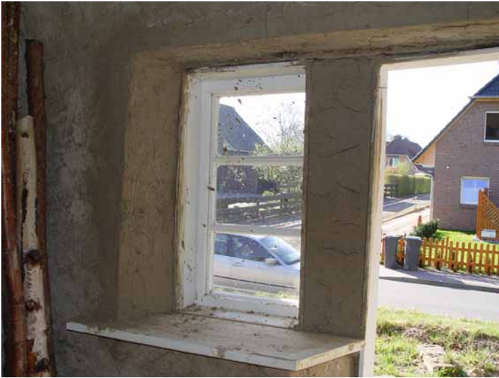
Die mit Strohlehm-Grobputz verputzten Fensterleibungen im Bereich der Eingangstüren, April 2007
